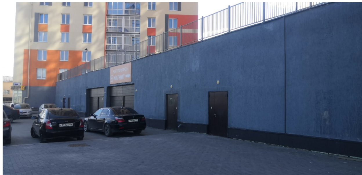
Главный фасад (Вид А). Фрагмент
